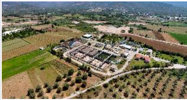
Milas Atıksu Arıtma Tesisi
