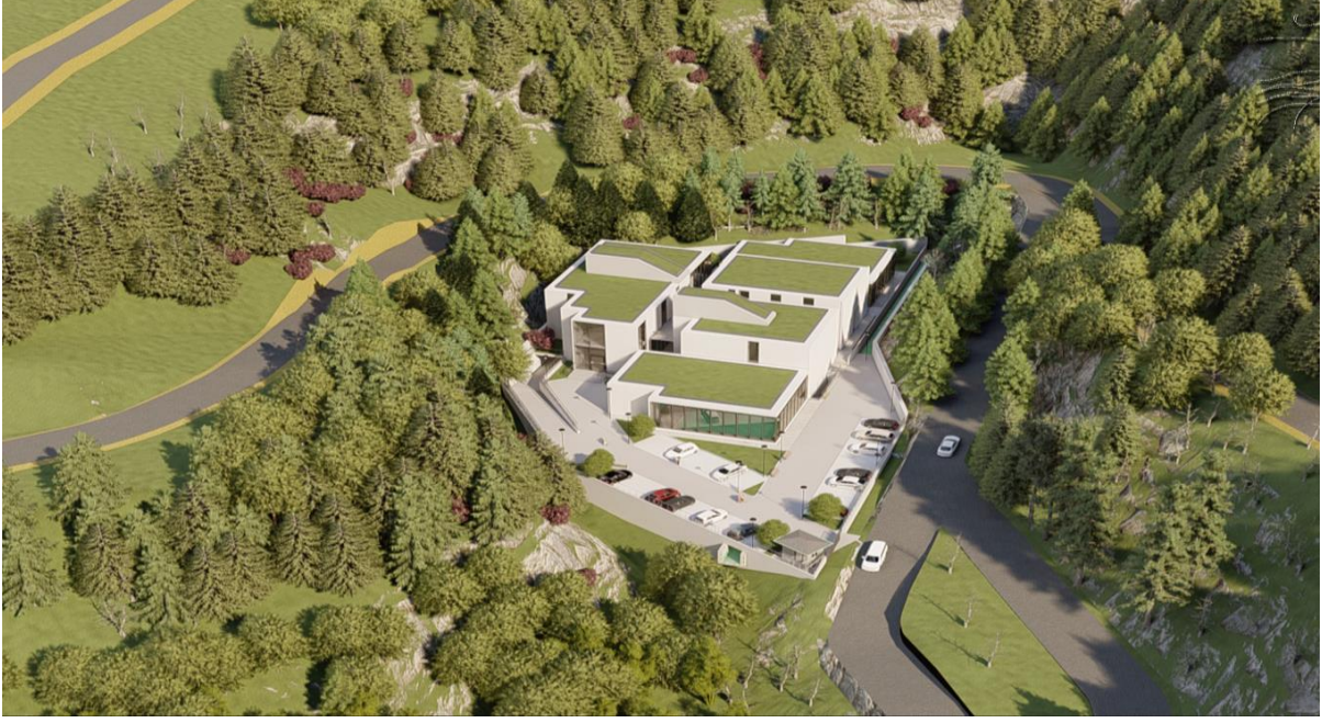
Yatağan Bağyaka Jeotermal Tesisi
