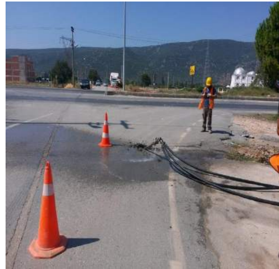
Menteşe İlçesi Atatürk Bulvarı Fiber Optik Alt Yapı Tesis Çalışması-Yatay Delgi
