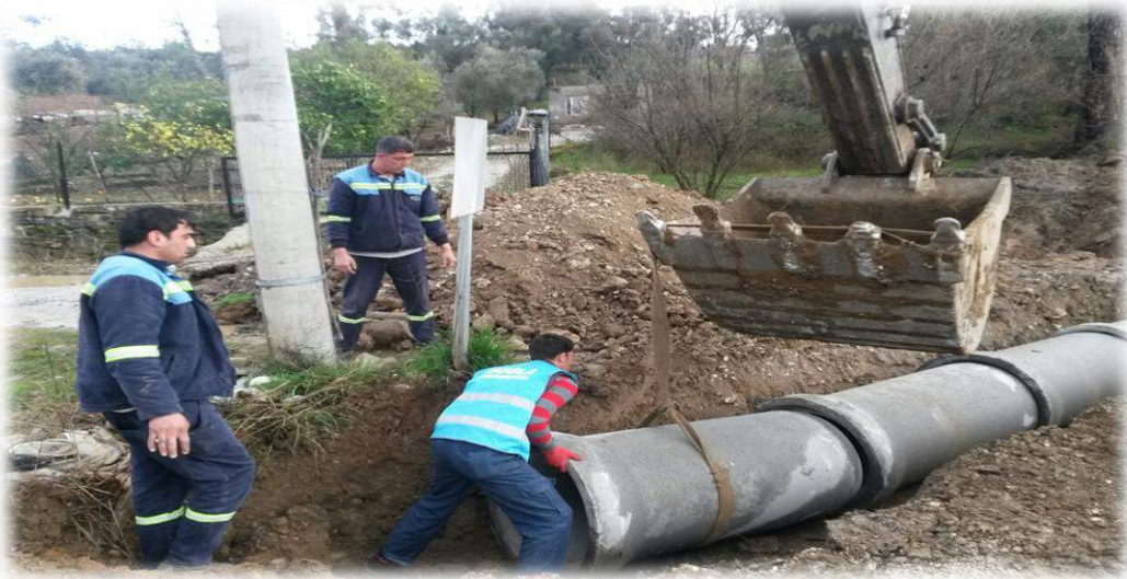
SEYDİKEMER - Atlıdere Mahallesi Sarı Süleymanlar Mevkii büz çalışması
