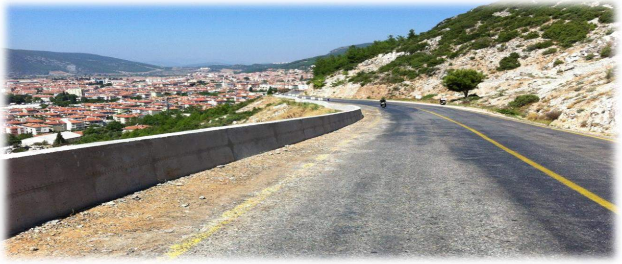
MENTEŞE - Yılanlı-Göktepe Grup Mahalle Yolu Ve Yerkesik-Akkaya Yol Ayrımı Betonarme Bariyer İşi
