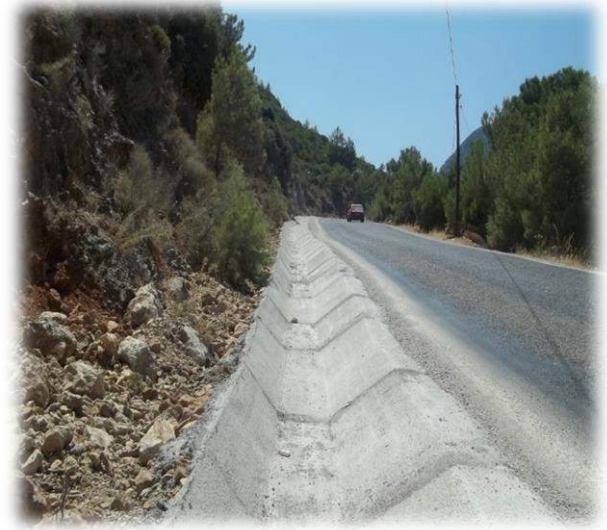
DATÇA-Sındı-Çeşme Yolu Şarmpol Hendek Ve Sathi Kaplama Çalışması
