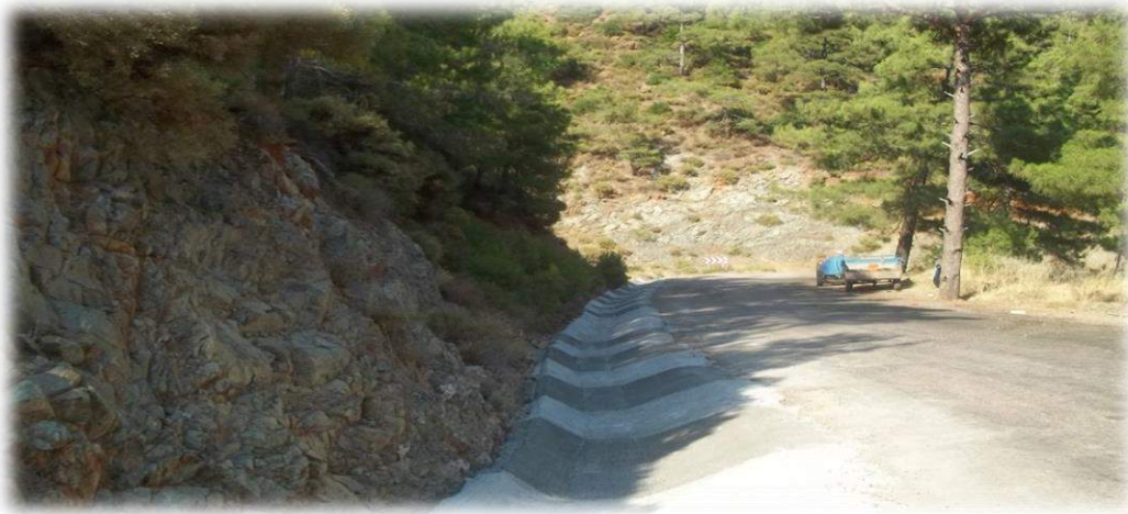
MARMARİS-Asparan Yolu Şarmpol Hendek Betonu Ve Sathi Kaplama Çalışması
