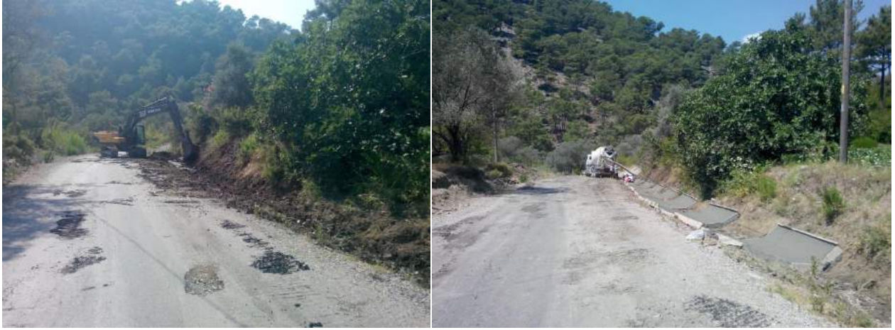
DALAMAN - Çöğmen yol kanal büz çalışması
