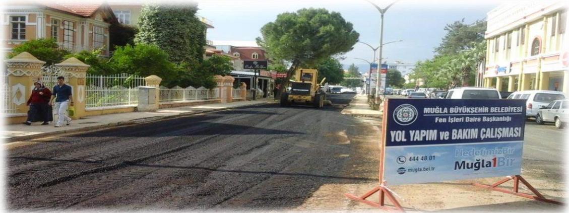
MİLAS - Atatürk Mahallesi Yol Bakım Çalışması
