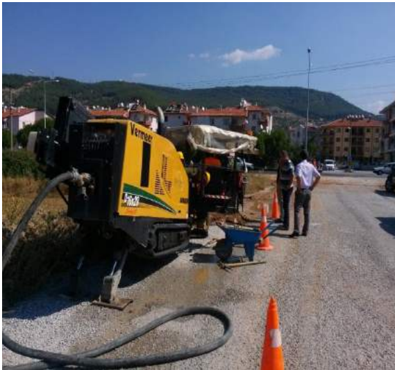
Menteşe İlçesi Atatürk Bulvarı Fiber Optik Alt Yapı Tesis Çalışması-Yatay Delgi
