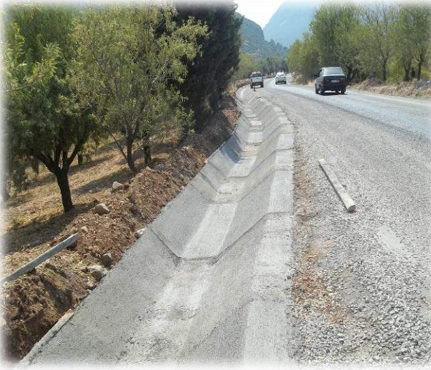
DATÇA-Sındı-Çeşme Yolu Şarmpol Hendek Ve Sathi Kaplama Çalışması
