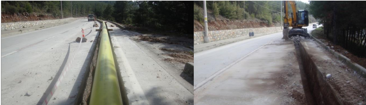
Menteşe Karamehmet Doğalgaz Altyapı Çalışması
