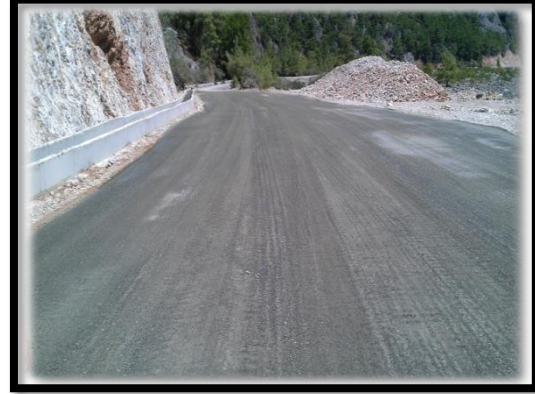
Ula Oyru-Aricilar 1. Kat Asfalt Sathi Kaplama
