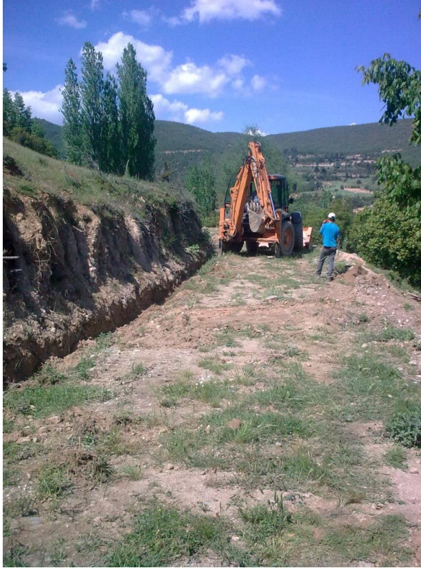
Mahallelerin Sulama Kanallarının Makineli Temizliği
