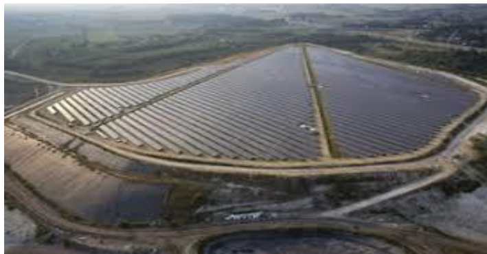
Şekil.30.Rehabilitasyon Sahasında Güneş Enerjisi
