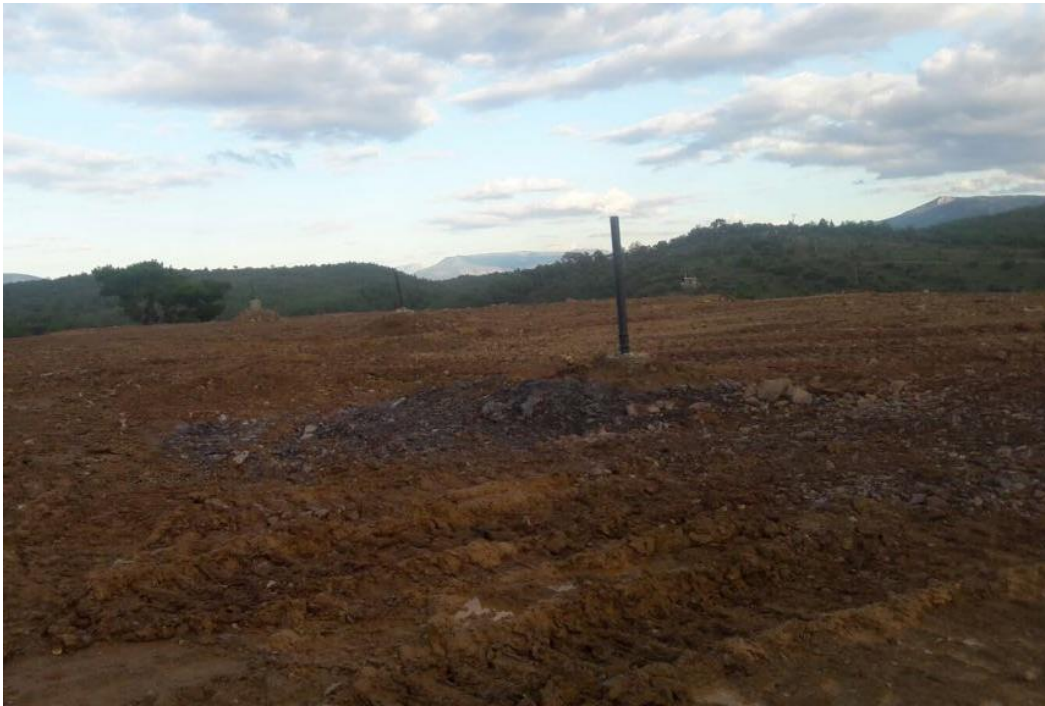
Şekil.23.Mumcular Vahşi Depolama Sahası Rehabilitasyon Çalışmaları Hafriyat Toprağı Kullanımı
