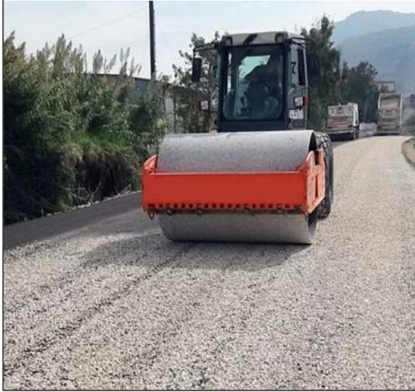
Şekil 75: Sathi Kaplama Yol Örneği
