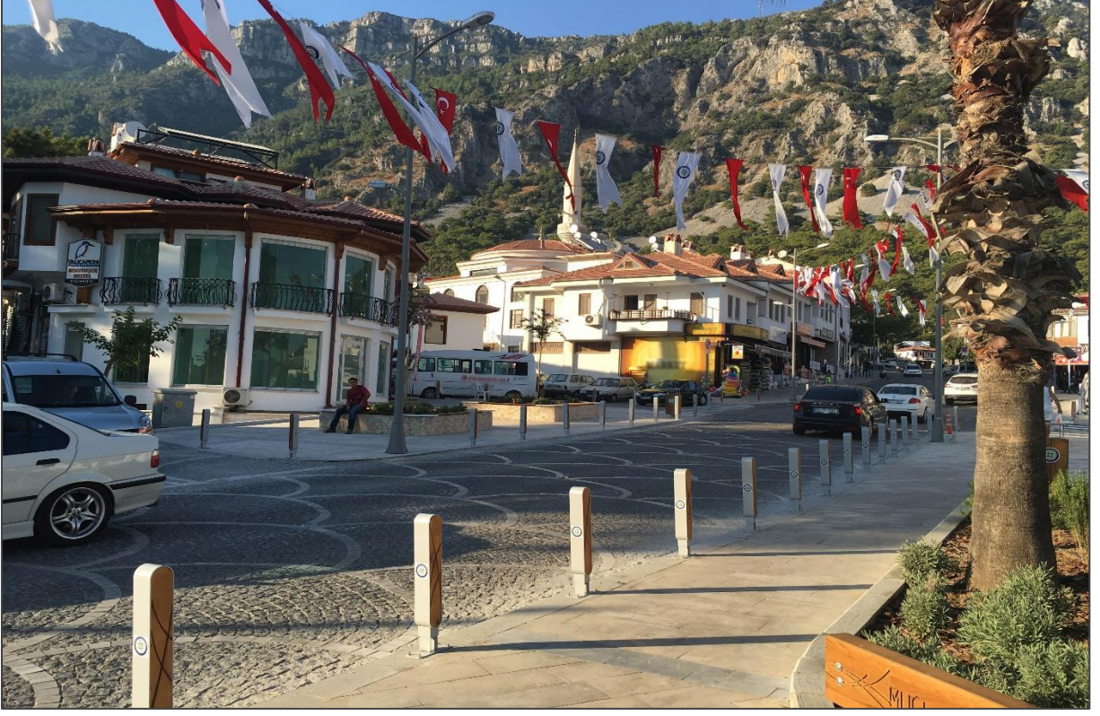
Şekil 78: Doğal Taş Döşeme Yol ve Kaldırım Örneği (Ula Akyaka Atatürk Caddesi)
