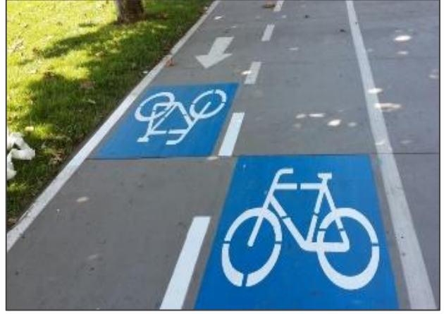
Şekil 83: Beton Kullanımı Örneği
