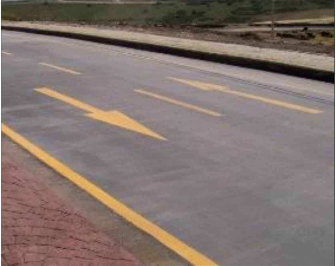
Şekil 76: Beton Yol Örneği
