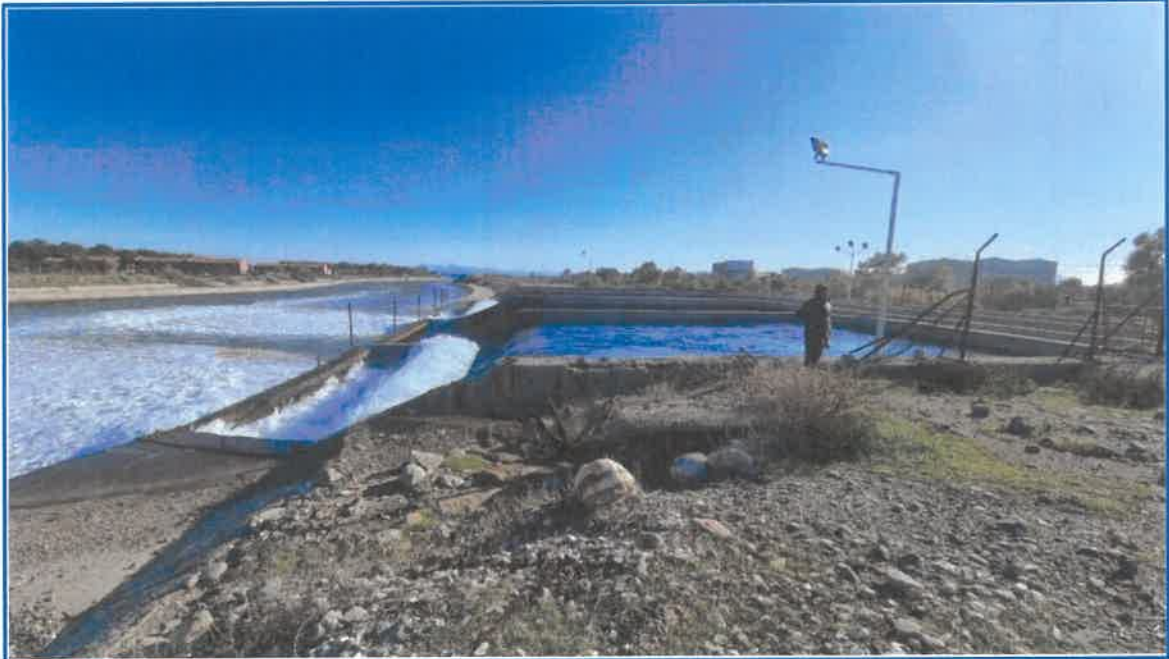
Resim 24 Kemerköy Termik Santrali'nden Hanay Deresi'ne yapılan soğutma suyu deşarjından birer görünüm -1-
