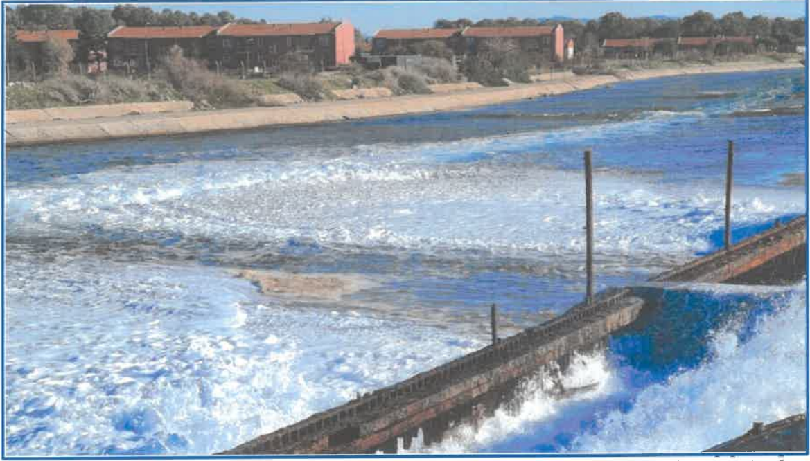
Resim 25 Kemerköy Termik Santrali'nden Hanay Deresi'ne yapılan soğutma suyu deşarjından birer görünüm -2- Kaynak: Milas-Ören Kanalizasyon Şebekesi ve Atıksu Arıtma Tesisi Projesi/ Nihai Rapor, 2022
